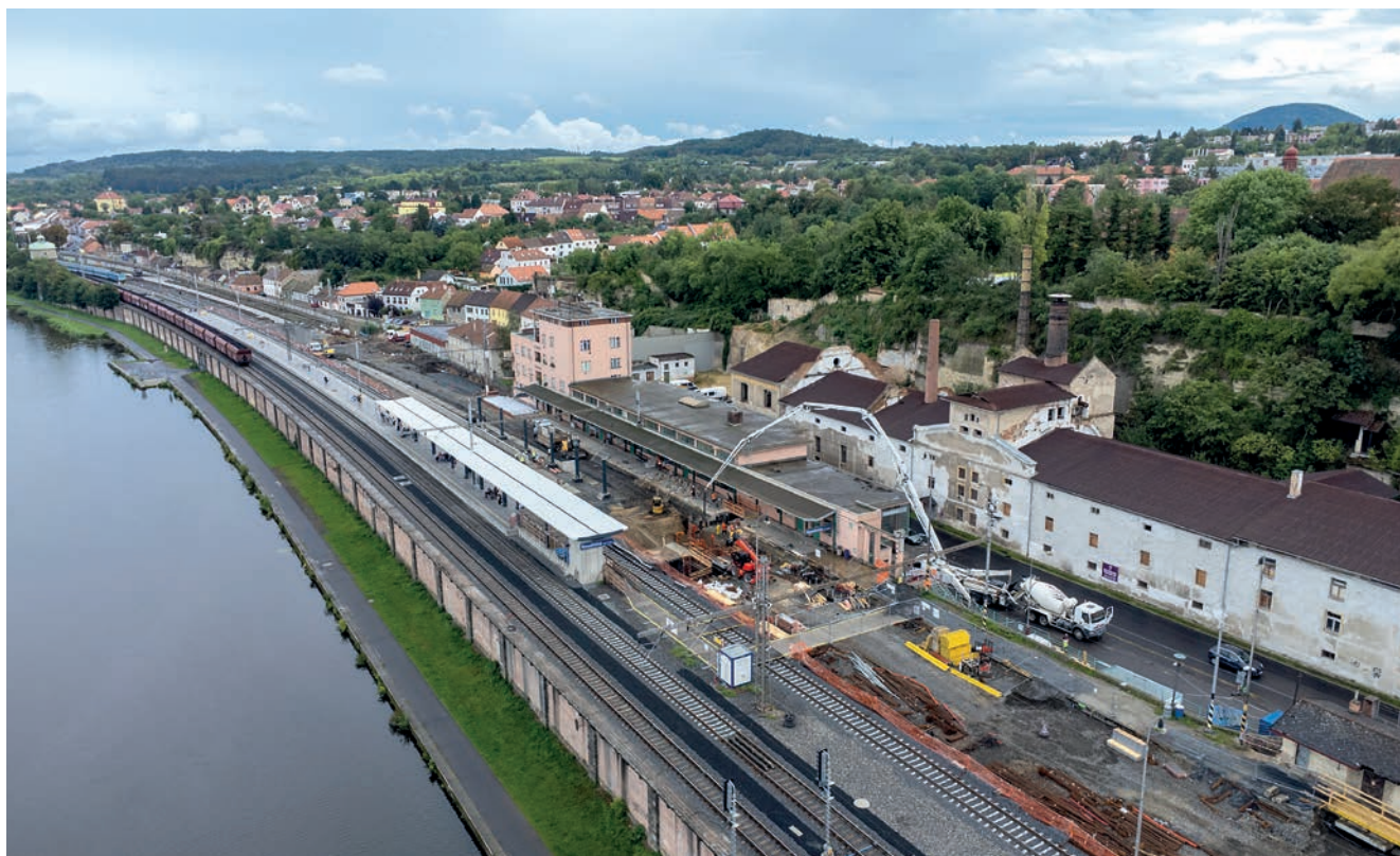
Roudnice nad Labem, betonáž podchodu (8. září 2022).
