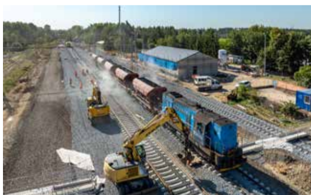
Postupná montáž nového železničního svršku
