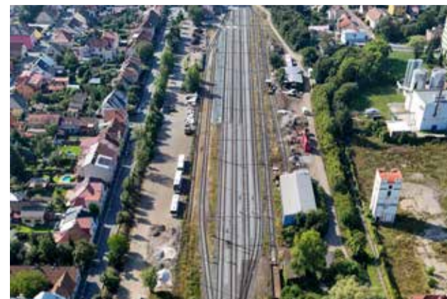
Stanice Nymburk město po rekonstrukci
