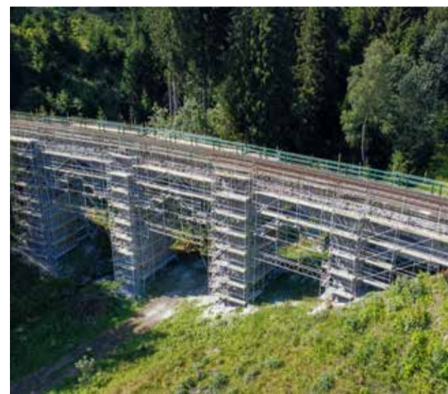
260 m dlouhý kamenný viadukt před stanicí Pernink
