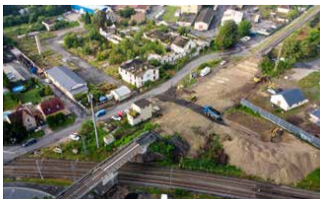
Sanace se týká 120 m dlouhého úseku trati
