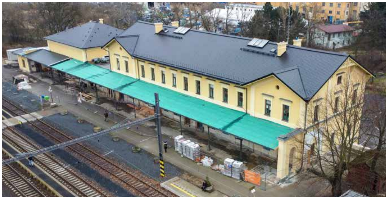
Více než třetina plánované rekonstrukce výpravní budovy je již hotová, a to včetně nové střechy
