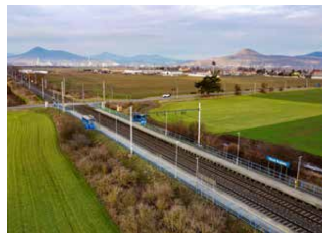
V součtu bude opraveno přibližně 6 km žel. svršku
