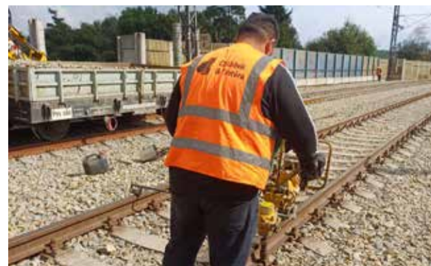
Naše společnost provádí práce na železničním svršku
