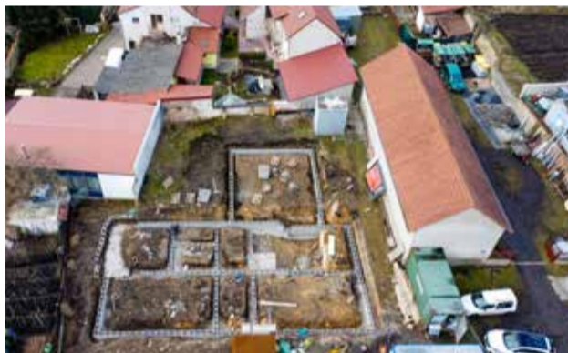
V místě výstavby kdysi stával původní obecní úřad
