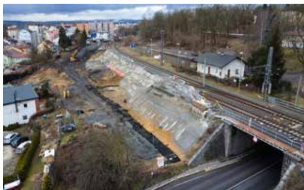
Budování náspu začne od mostu směrem do Chebu
